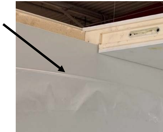
插图 10：安装壁元件时部分撕下保护膜
