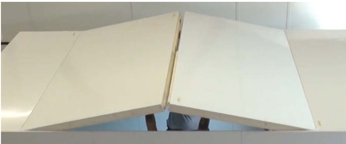
插图15：安装最后一个天花板
