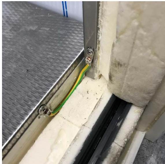
插图13：将底板与壁元件连接
