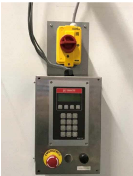
插图 59：安装在控制器盒上方的主开关（不带盖板的视图）
