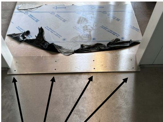
插图 23：安装门槛坡道
